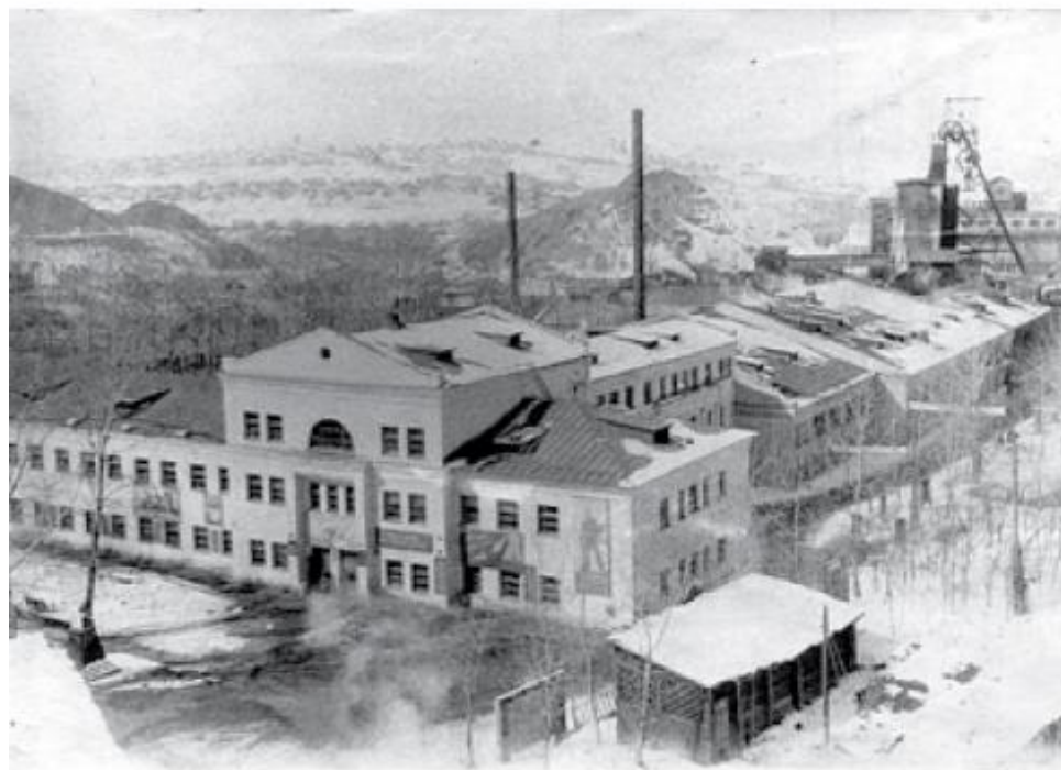
АБК шахты «Капитальная-1»
